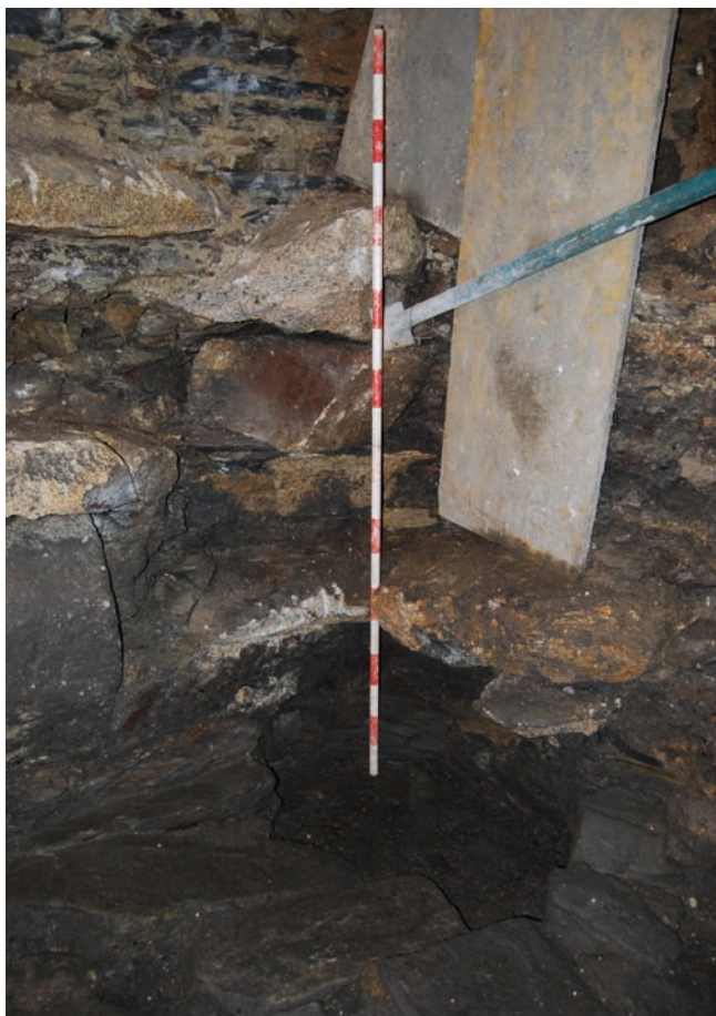
Fig. 5. Cimentación do actual inmoble (UEM 232) sobre un pozo de época moderna (UE 216).
