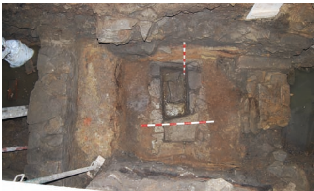
Fig. 15. Canle de evacuación de augas (UE 135), visto desde o N, localizado baixo a beirarrúa da marxe L. da calzada.
