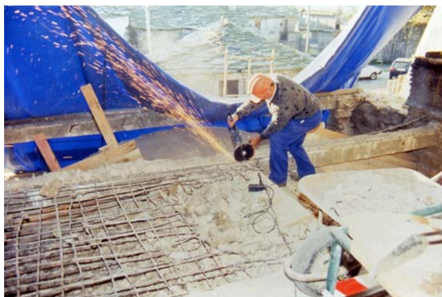
Fig. 203: Inicio del desmontaje de la planta superior y eliminación de la placa divisoria (Fotos estudio César Portela)
