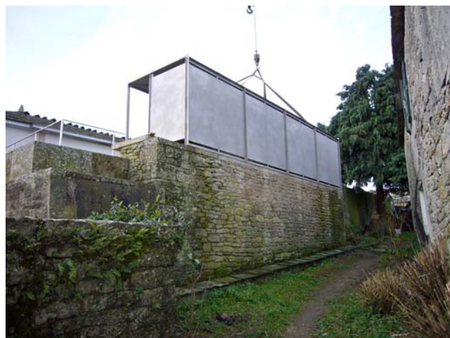
Fig. 234: Instantáneas del montaje de la estructura protectora del muro superior (28 de febrero de 2005)
