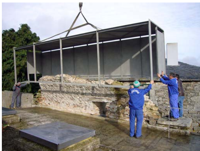
Fig. 234: Instantáneas del montaje de la estructura protectora del muro superior (28 de febrero de 2005)
