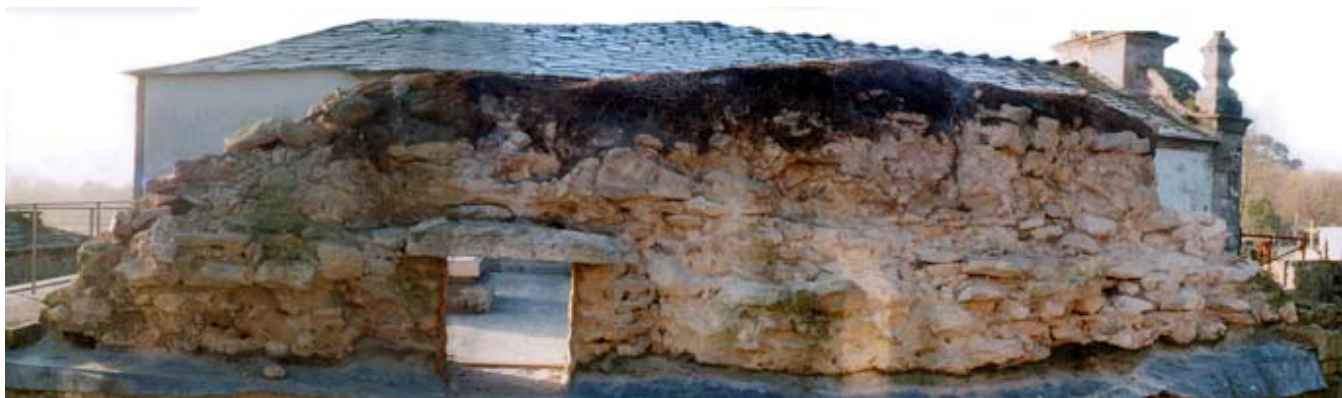
Fig. 237: El arranque de bóveda que conforma el muro superior tal cual se encontraba bajo la lona (foto José López)
