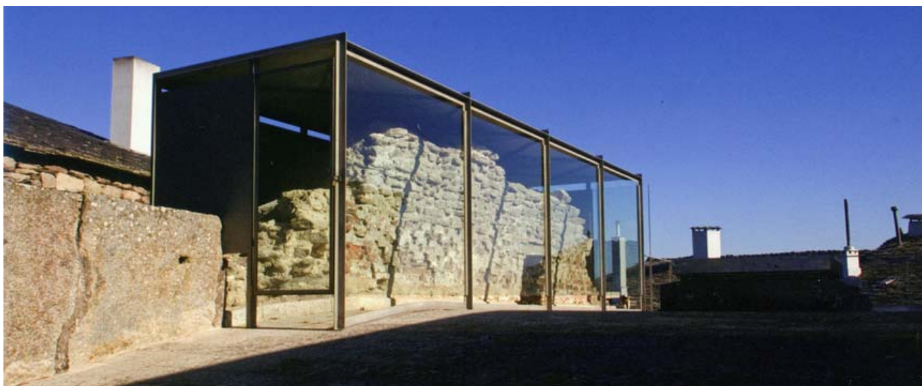
Fig. 235: El muro superior bajo la estructura de protección una vez culminado su montaje (fotos Portela, 2008)
