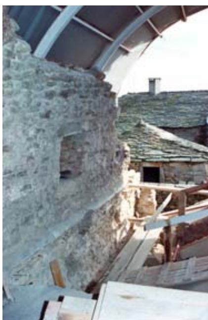
Fig. 204: Estado del muro superior, el pavimento del patio antes de la restauración y parte alta del machón sur (Fotos estudio César Portela y José López)
