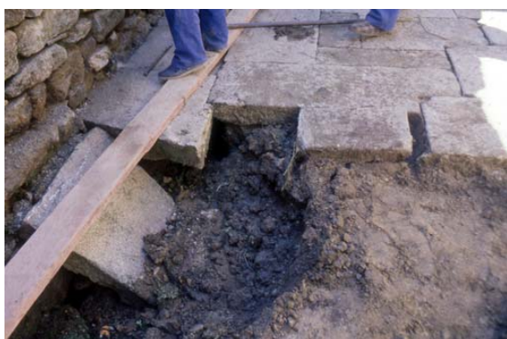
Fig. 205: Imagen del suelo donde se asientan las losas del pavimento del patio. A la derecha, uno de los dibujos para toma de datos realizados por José López, jefe de obras de RESCONSA.
