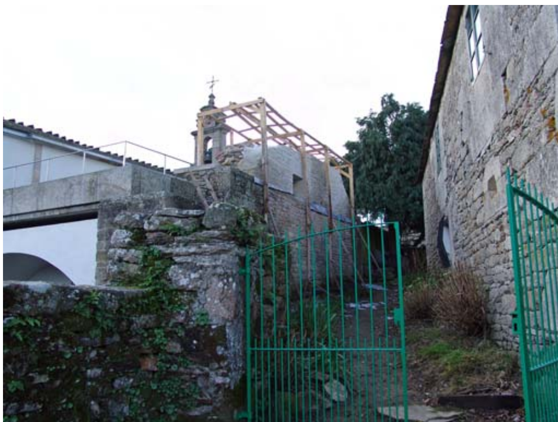
Fig. 233: El muro superior el 29 de noviembre de 2005. En primer plano se aprecia una nueva verja cuya instalación estaba contemplada en las obras de acondicionamiento del entorno del monumento (foto equipo César Portela)
