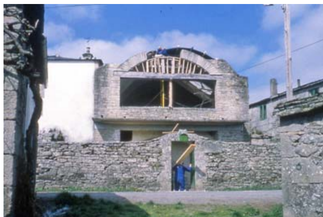
Fig. 203: Inicio del desmontaje de la planta superior y eliminación de la placa divisoria (Fotos estudio César Portela)
