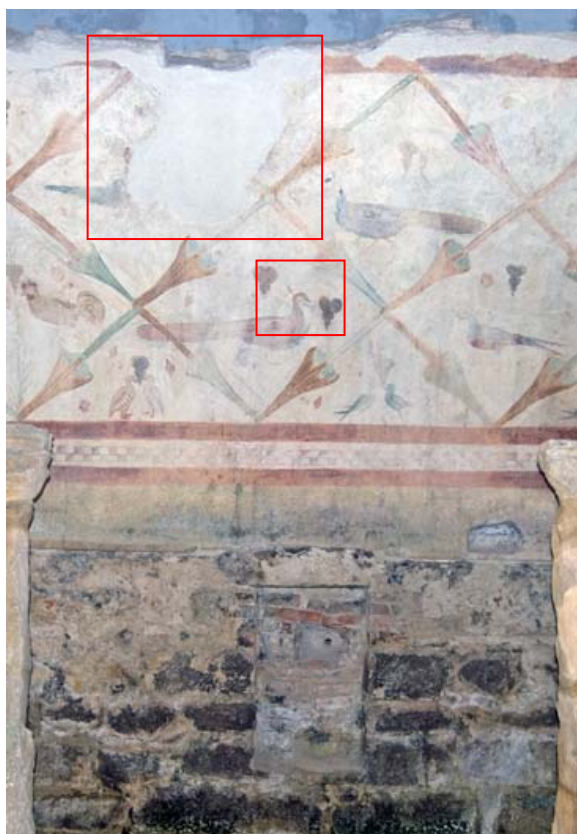
Fig. 247: A la izquierda, zona de la bóveda conservada donde más afectaría la superposición de la iglesia parroquial (foto del autor). Sobre estas líneas detalle de la grieta creada por presión (foto Paco Vilabarro).
