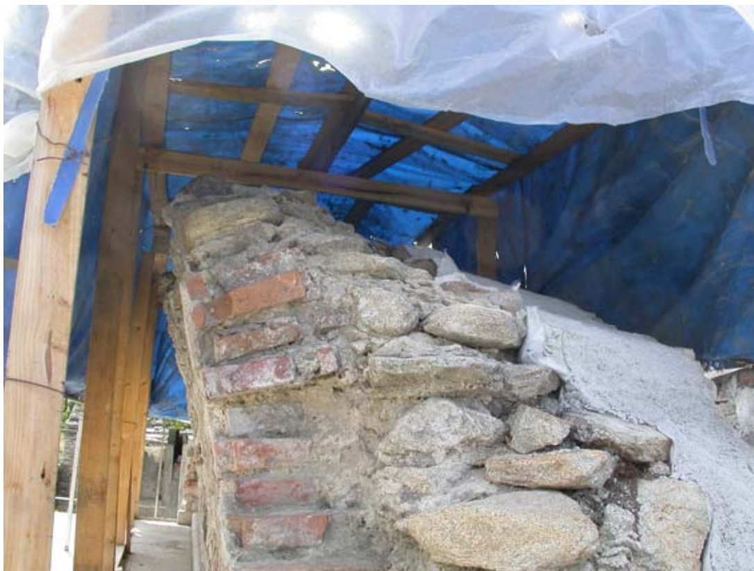
Fig. 6: Detalle de la obra con ladrillo para el arranque de la bóveda del muro superior
