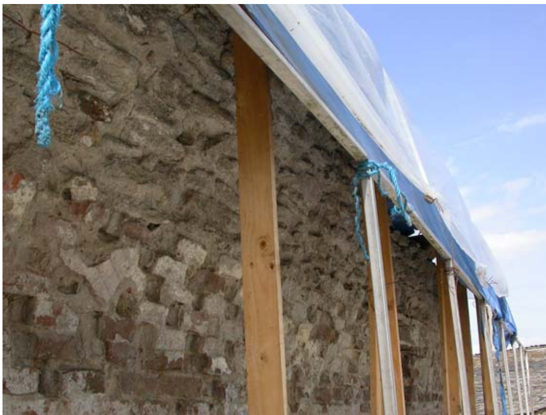
Fig. 7: Hiladas de ladrillo en la mitad inferior de la foto del muro con restos de pintura
