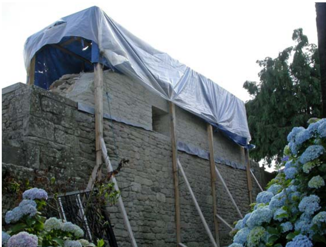
Fig. 232: Situación del muro superior el 29 de junio de 2005 (foto del autor)
