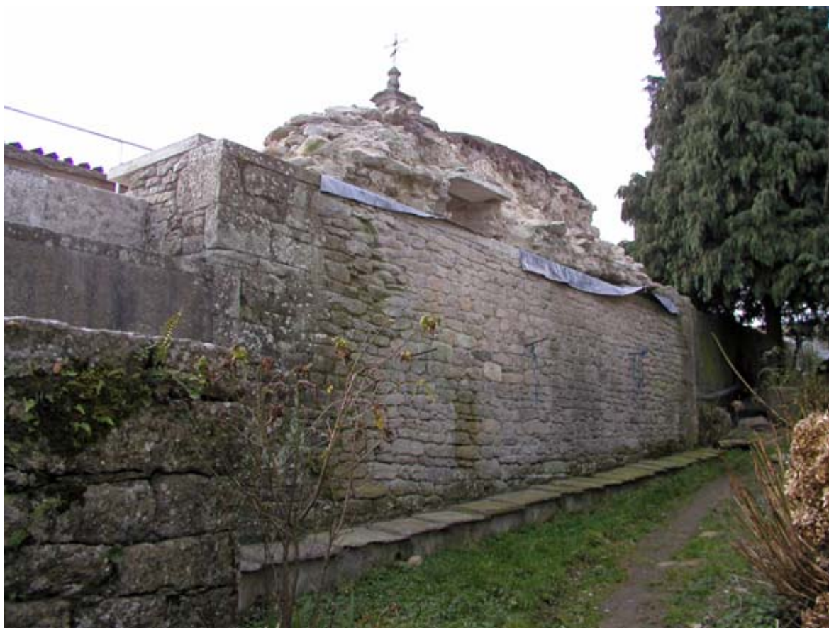
Fig. 237: El arranque de bóveda que conforma el muro superior tal cual se encontraba bajo la lona (foto José López)
