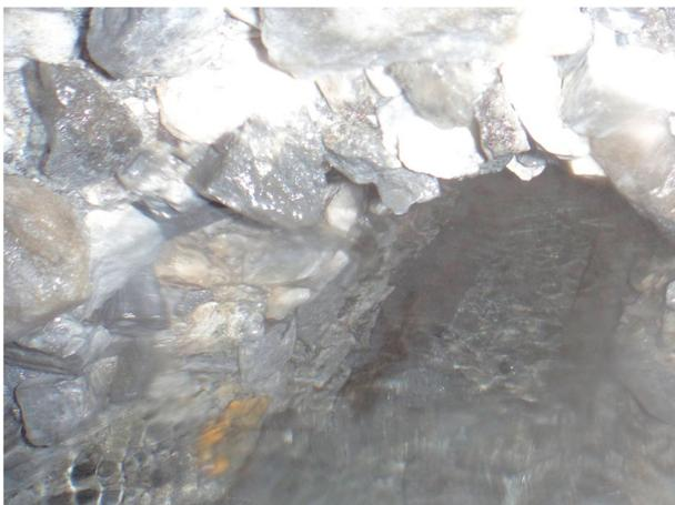
Figura 6: Fotografía de la autora del canal inferior, situado en la cara N del pozo, en el que se aprecia los restos de la caja de madera presente en la conducción por la que se abastece de agua termal al pozo-receptor (Fig. 2, 1 y Fig. 5).
