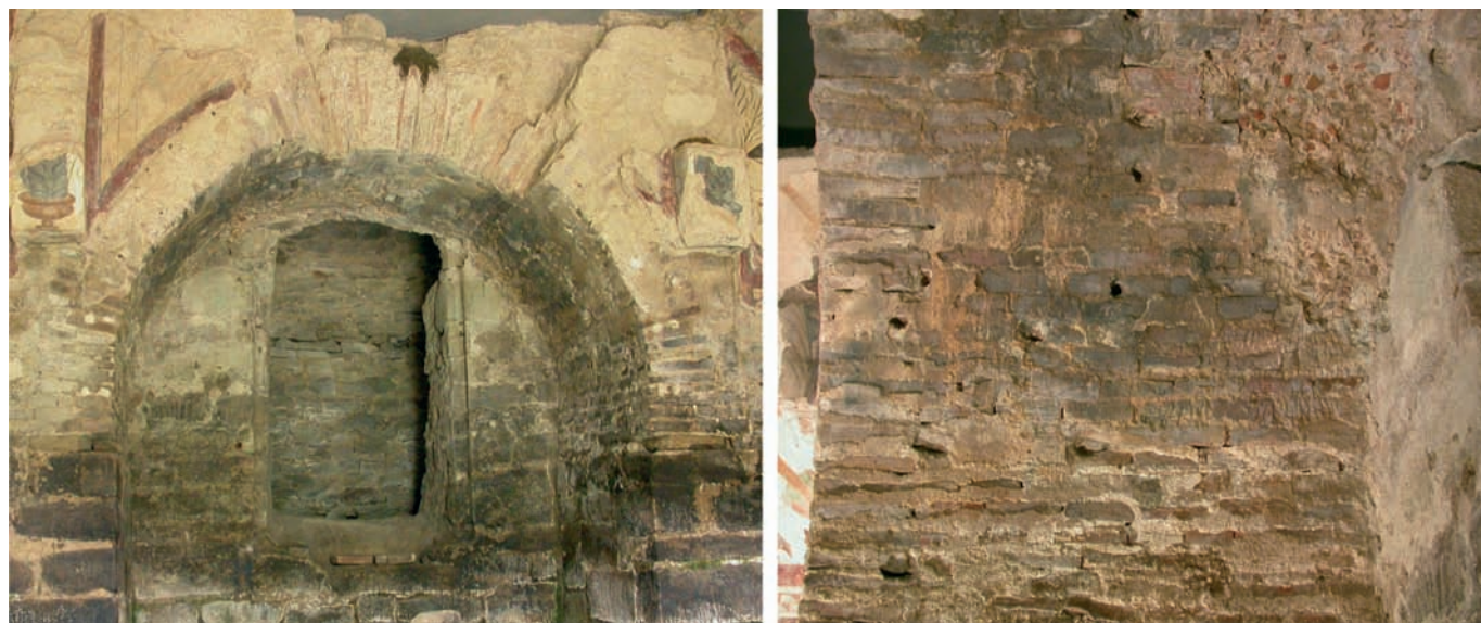
Fig. 11. Fotografías de la bóveda del ábside
