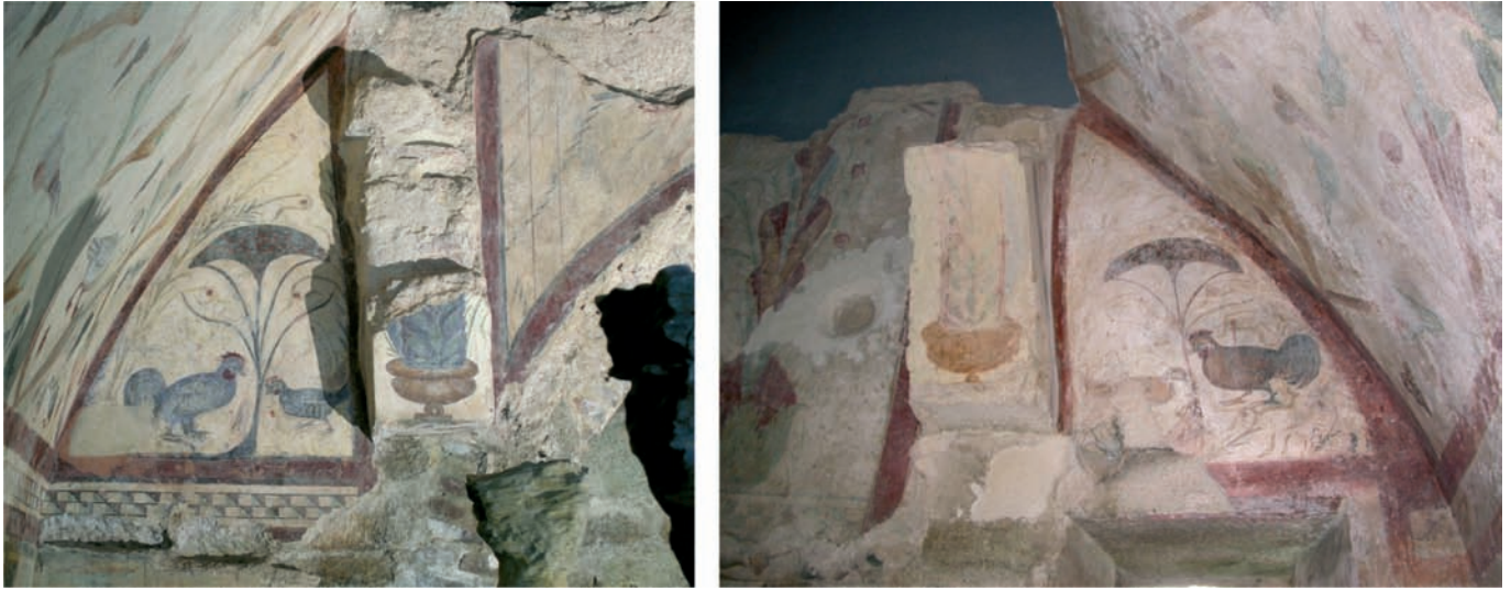
Fig. 15. Fotografías de los enjarjes S de los alzados W (imagen de la izquierda) y E (imagen de la derecha) en las que se pueden apreciar las deformaciones de los mismos y cómo la banda que enmarca las pinturas se adapta a éstas
