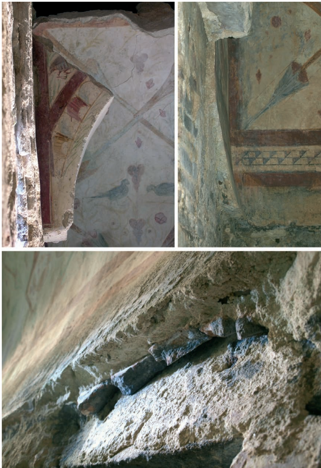
Fig. 17. Distintas fotografías de los revocos que cubren los muros del aula. En la imagen superior izquierda (muro E) se observan las distintas capas de mortero que se aplican. En esta rotura se puede ver una estratigrafía bastante completa de la preparación de las pinturas, en la que se distinguen, al menos, tres capas y el enlucido. En la imagen superior derecha (muro W) se puede apreciar cómo se engrosa el mortero, hasta llevarlo a la altura a la que se localizaría la imposta de mármol, que en esta zona se ha perdido pero permanece su impronta. En la imagen inferior (muro S) se pueden ver los fragmentos de ladrillo dispuestos bajo el mortero sobre el dintel de la hornacina.
