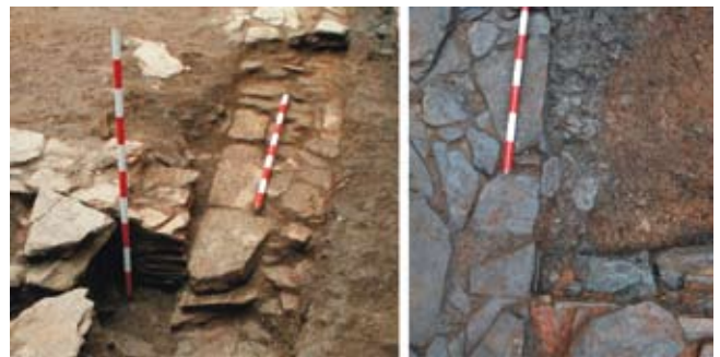
Fig. 7. Á esquerda muro U.E. 319 arrimado ao muro mestre U.E. 338. Á dereita caixa de cimentación do muro U.E. 320 cortando a caixa de cimentación do muro mestre U.E. 338.
