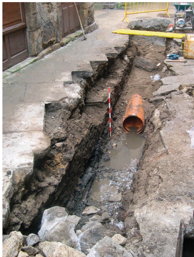
Fig. 4. Vista xeral da parede sur da canle decimonónica e o novo tubo de saneamento.
