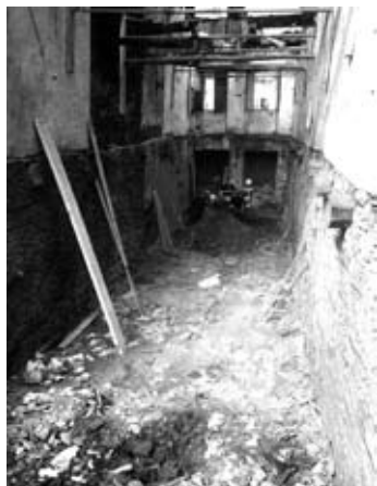
Fig. 5: Estado do soar previo á intervención
