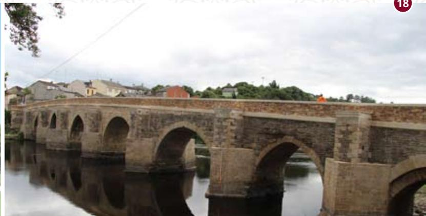
grampas con dobre cola de miñato, marcas de panca, inscricións, etc. É posible que a ponte primixenia tivera oito arcos de 10,40 m, cunha composición simétrica, piares de 4,70 m de espesor cun tallamar semicircular na súa fronte de 2,35 m de radio, e rasante horizontal, cunha tipoloxía habitual noutras pontes de *Hispania*. A súa lonxitude, duns 120 m, e a súa anchura, de 7 m, dan unha idea da monumentalidade desta obra.
